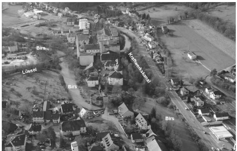
Die Situation von Birs, Lüssel und Kraftwerkskanal in Zwingen.
