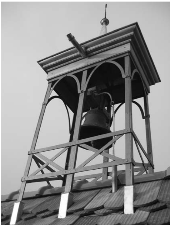
Ein filigraner Dachreiter mit spitzem Turmhelm und Glocke bekrönt das Dach.
