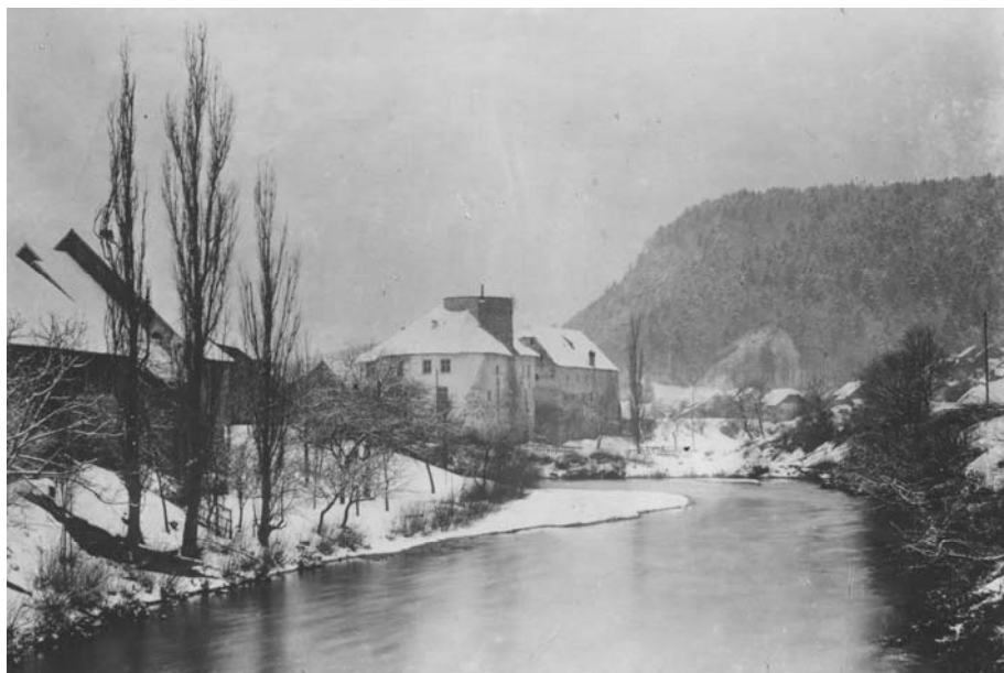
Schloss Zwingen um 1900 Bergfried im Dachumbau
