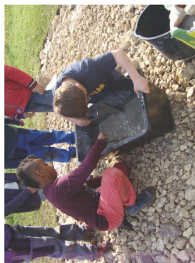
Beton mischen muss man auch, für die Stützen.
